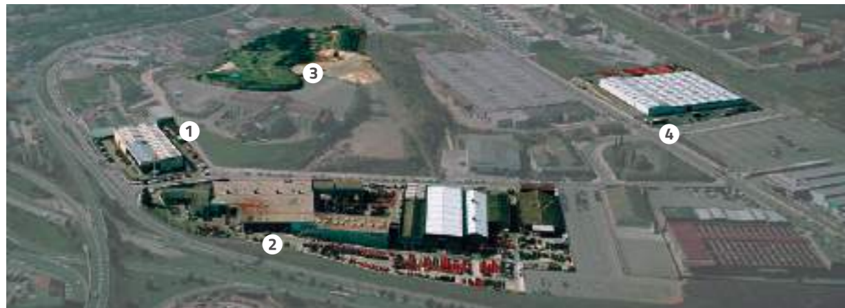
1. Sede central 2. Planta de montaje 3. Area pruebas, demostración y formación 4. Almacén máquinas terminadas
